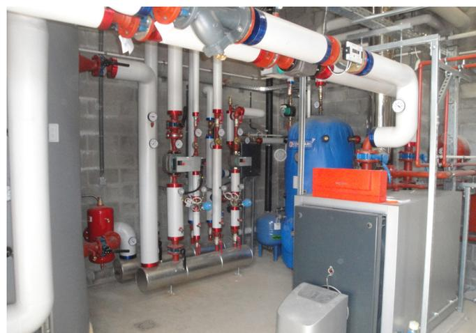
Situé à Flémalle, cette société spécialisée dans le nettoyage industriel a fait appel à CORETEC Energy pour réduire sa consommation thermique. Une chaudière de 150kth, alimentée par des plaquettes forestières a ainsi été installée permettant de générer un gain annuel de 40.500 €
