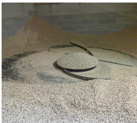
L'Institut de Schaltin a fait appel à Coretec Energy afin de réduire ses consommations thermiques. La mission a consisté à l'installation d'une chaufferie biomasse alimentée en pellets et d'une chaudière mazout de 350kW en back-up. Un réseau de chaleur a également été mis en place afin d'alimenter 10 sous-stations d'échange thermique. Coretec s'est ensuite occupé de la régulation complète de la chaufferie et des 10 bâtiments.
